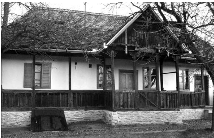
Casa comunității din Sânsimion - Foto: Kelemen A. Márton
