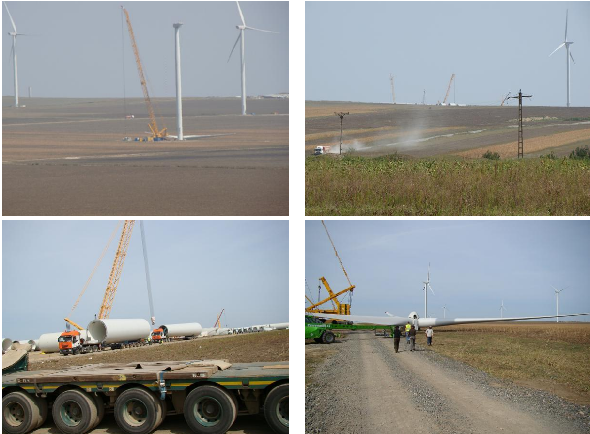
Figura nr. 5-8 Lucrări de construcție pentru un parc eolian
