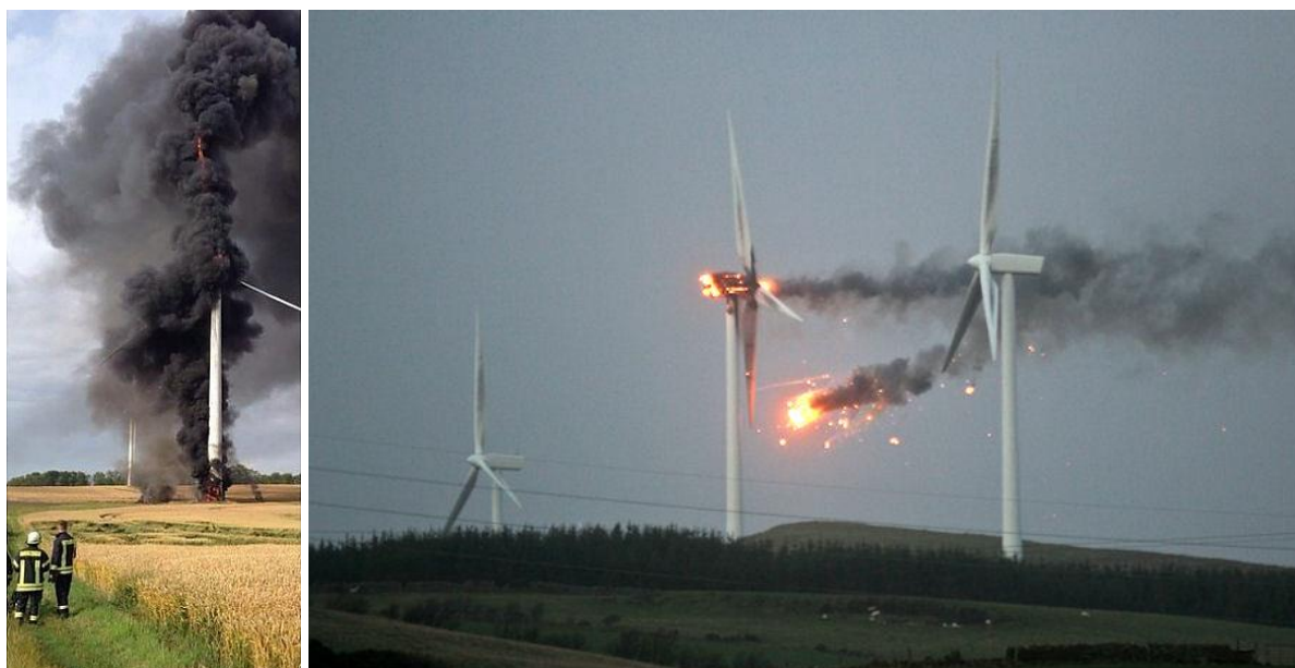
Figura nr. 5-7 Exemple de incendii la turbinele eoliene
